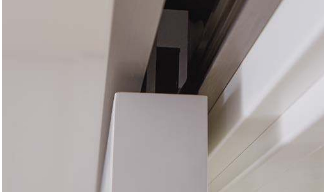
Befestigung einer Holztür im Schiebetürbeschlag LINE
