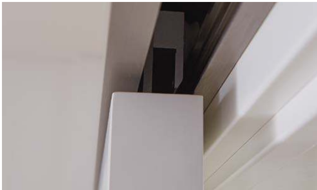
Befestigung einer Holztür im Schiebetürbeschlag LINE
